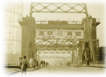
第2高炉再開火入れ式 当日の大船橋の看板
