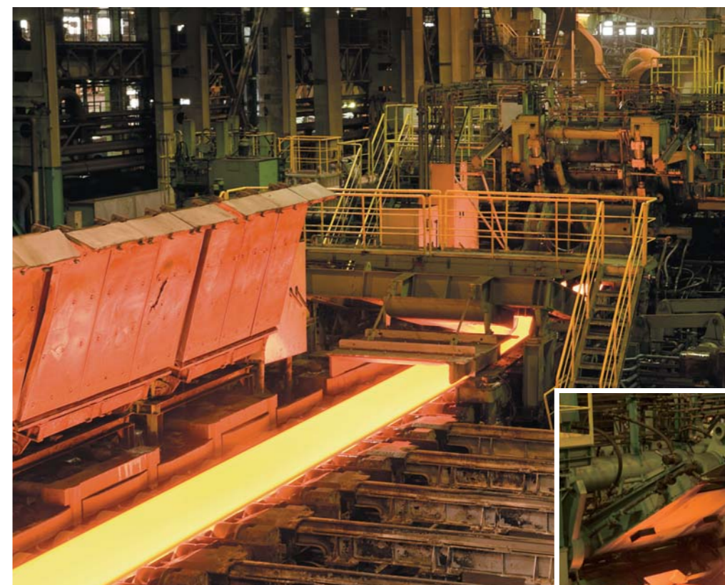
熱延工場 仕上圧延機(入側)
