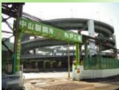
転炉南門ゲート
