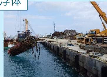
浮体と係留索を切断後、起重機船で係留索とアンカー回収
