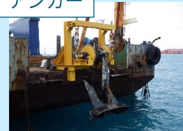
浮体と係留索を切断後、起重機船で係留索とアンカー回収
