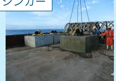
浮体と係留索を切断後、起重機船で係留索とシンカー回収
