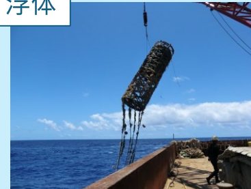
浮体と係留索を切断後、起重機船で係留索とシンカー回収
